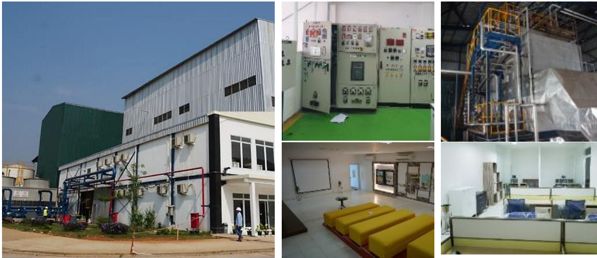
Gambar II-9. Pembangkit Listrik Tenaga Sampah (PLTSa) Merah Putih
